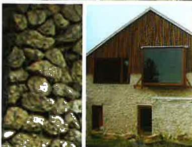
Matériaux : rilles métalliques pour plantes grimpantes, mur en gabion (caisson en treillage métal rempli de caillasse), pignon en moellon enduit à pierre vue et clins de bois associés aux fenêtres cadrées
